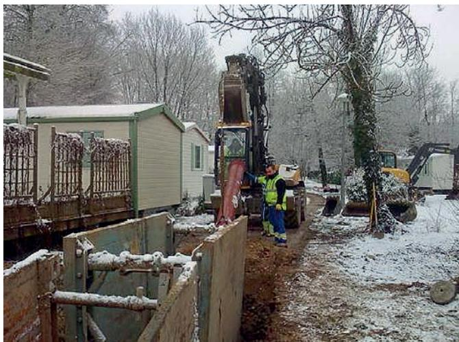
Dans le but de raccorder les effluents de la station du chef-lieu de Belmont-Tramont à la station de La Calabre, la pose de conduites (gravitaires et refoulement) a été réalisée dans le camping des Trois Lacs ainsi que dans la traversée des Chaudannes (RD 916a et amorce de collecte sous la RD 35).
